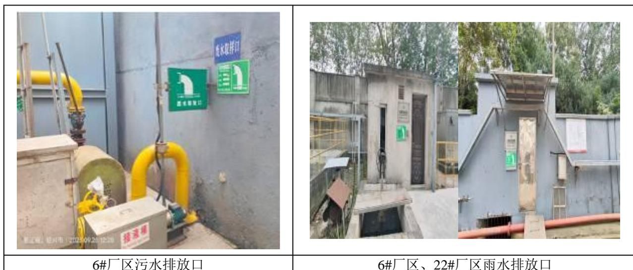
企业在6#厂区废水排放口及废气RTO焚烧装置排放口安装在线监控设施，并与环保部门联网，监测因子包括：流量、pH、COD<sub>Cr</sub>、氨氮、总氮及非甲烷总烃；22#厂区固液焚烧炉废气排放口安装在线监控设施，并与环保部门联网，监测因子：流量、颗粒物、CO、NO<sub>x</sub>、SO<sub>2</sub>、HCl；在线监控设施相关备案文件详见附件5。
